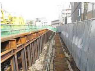
鋼管杭の打設
