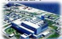
浮島処理センター
