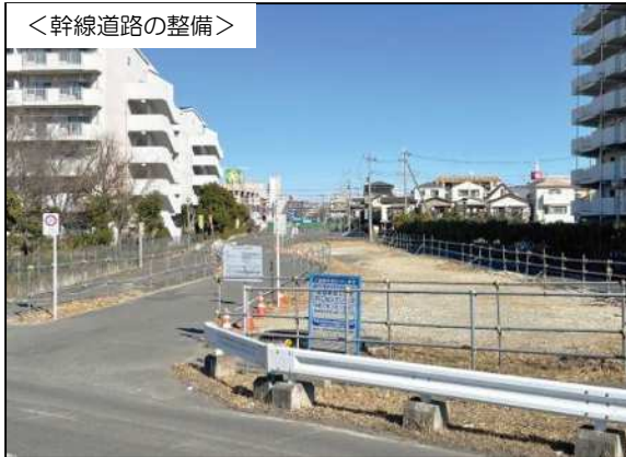
宮内新横浜線（子母口）【整備前】
