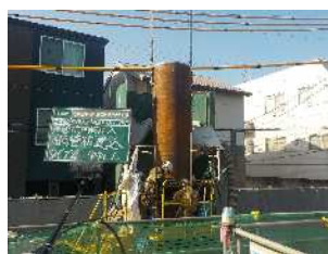
鋼管杭の打設
