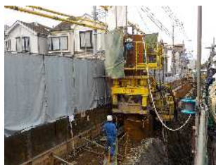
鋼管杭の打設
