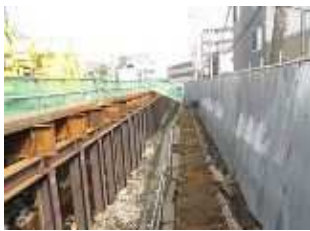
鋼管杭の打設
