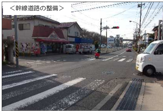
世田谷町田線（片平）【整備前】
