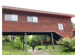
鳥の棟渡り廊下
