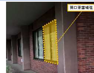
（大ホール棟の耐震補強）
