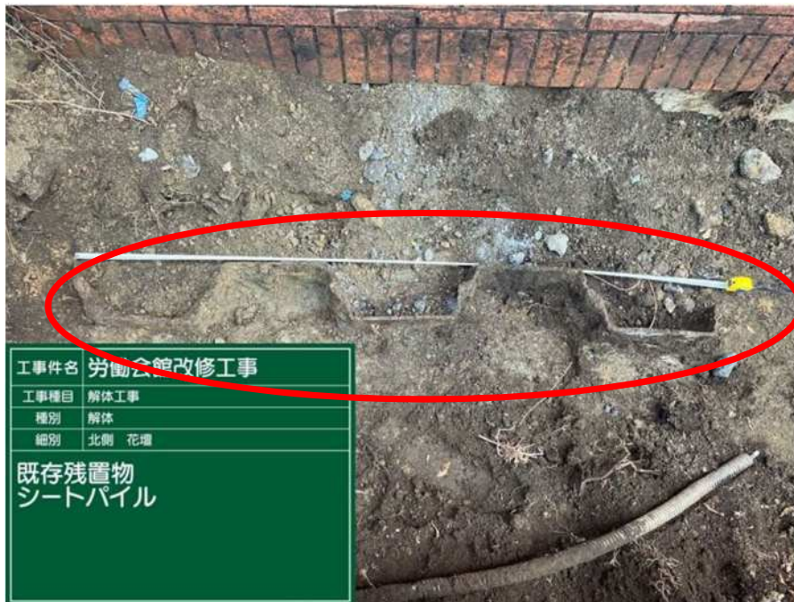
【埋設シートパイル】
