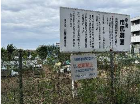
【参考写真】老朽化が進む共有設備（看板等）の例
