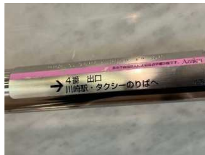
階段手すりの「点字案内表示」
