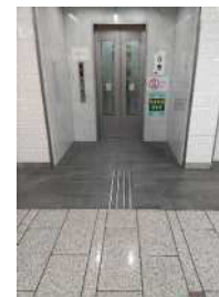
点字ブロック（エレベーター前）
