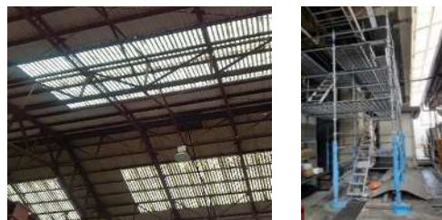
青果卸売場棟天井(左)と改修工事(右)
