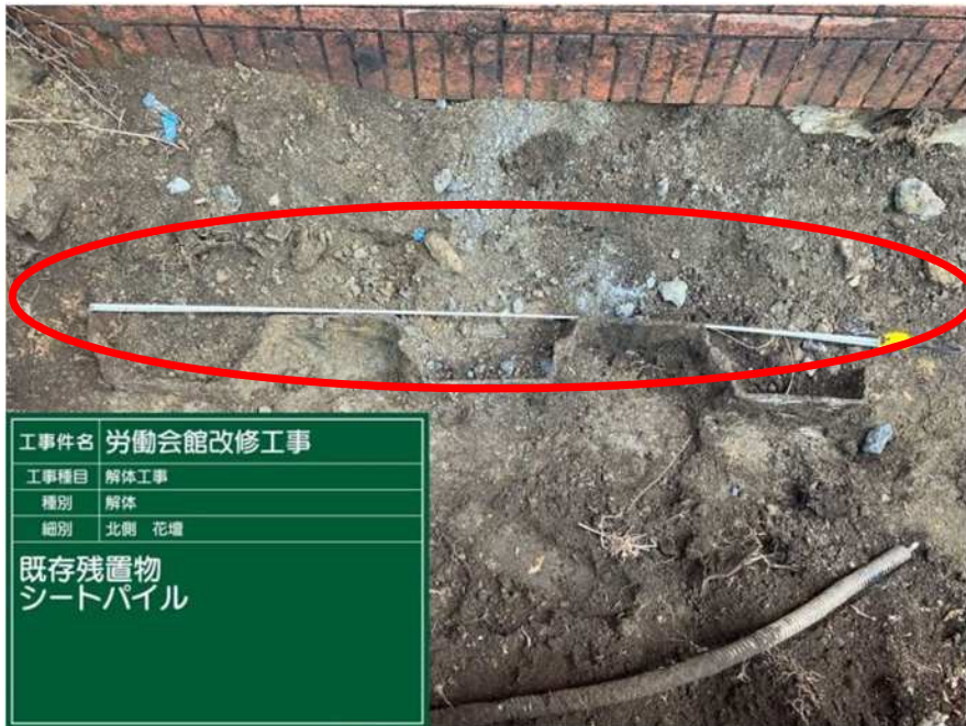
【埋設シートパイル】
