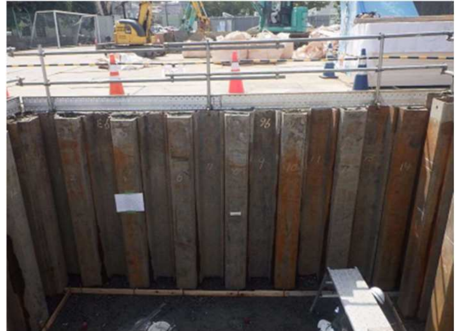
【他工事での事例】
