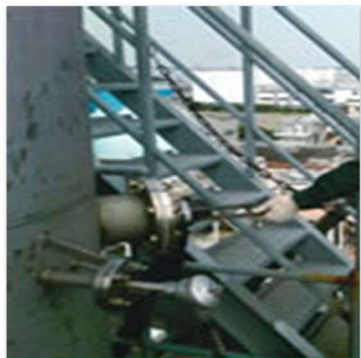
工場の立入によるばい煙測定
