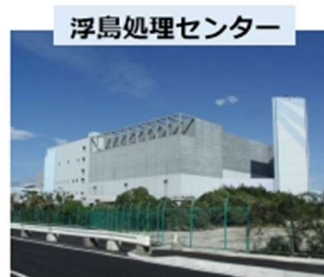
H7年10月竣工
