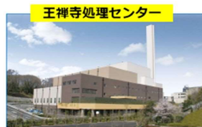
H24年3月竣工
