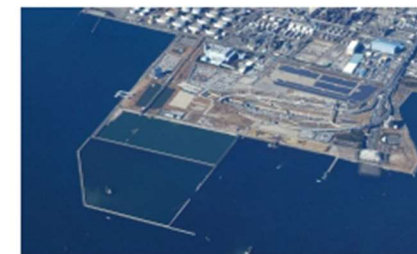
浮島2期廃棄物埋立処分場
