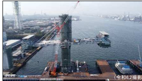
② 主橋梁部MP1～MP3
