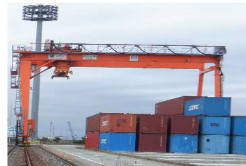
トランスファークレーンの更新
