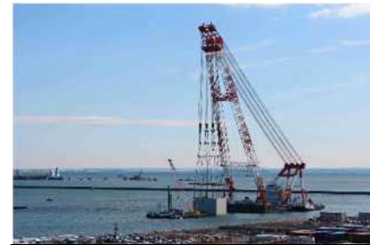
ケーソン据付（令和2年2月）
