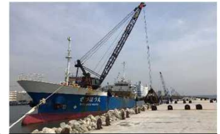
裏込工（令和4年5月）
