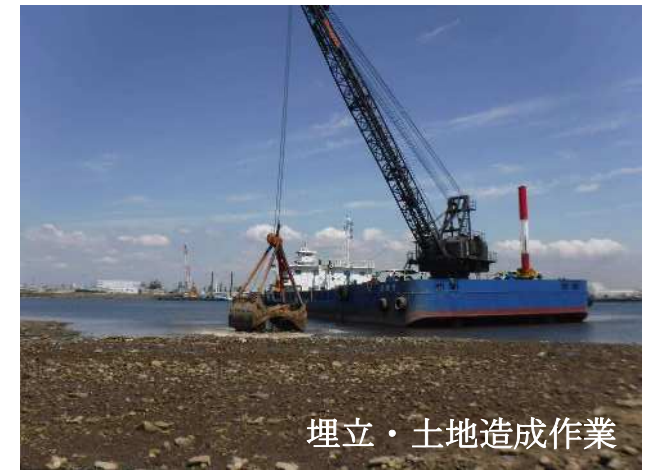
港内浚渫作業
