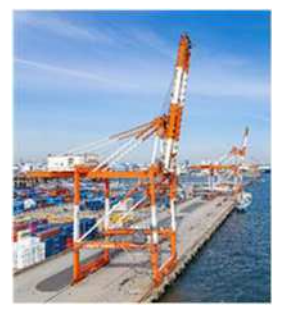
荷役機械 (ガントリークレーン)
