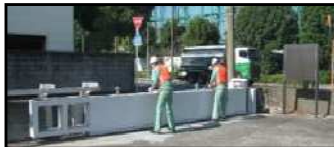
改良した海岸保全施設(防潮扉)の閉鎖状況
