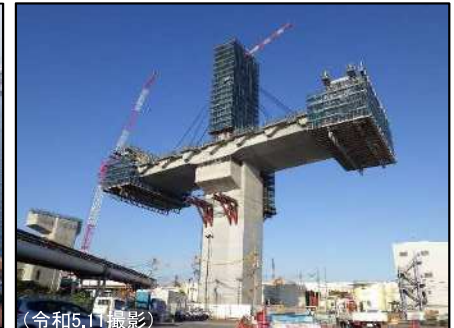
③ 橋脚MP5,6
