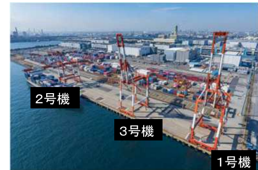
ガントリークレーン1、2号機の更新
