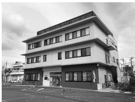
上平間営業所（事務所棟）
