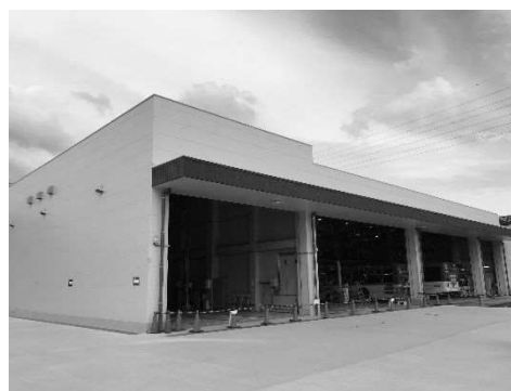
上平間営業所（整備棟）
