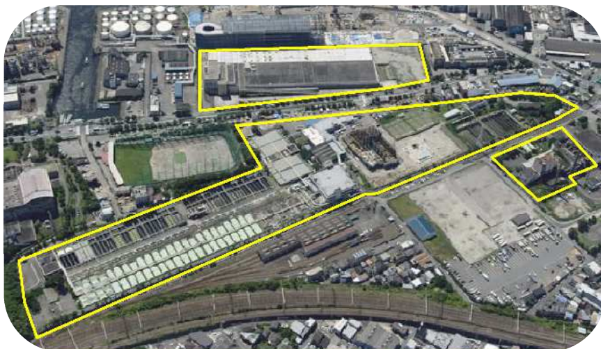
入江崎水処理センター
