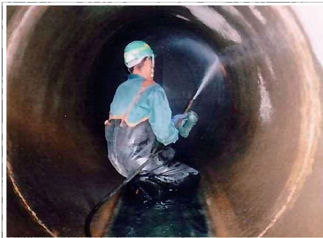
下水管きょの清掃作業状況
