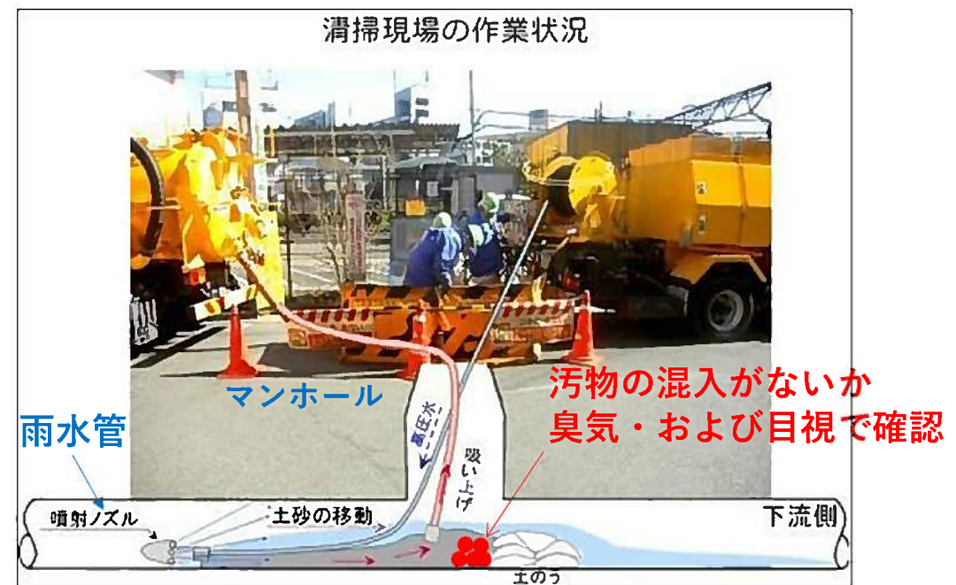
雨水管清掃作業時における汚水混入の確認方法
