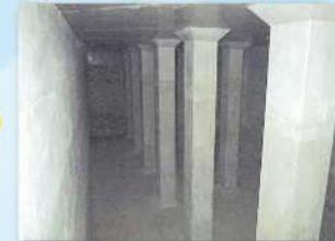
次亜塩素酸ナトリウムで殺菌、消毒した水を貯める施設です。家庭や企業の使用量に応じて配水量を調整することができます。上部に太陽光パネルを設置しています。
