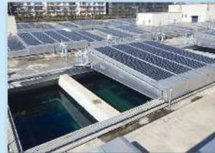
アンラサイト(無煙炭)と砂の層を通して微細な浮遊物を取り除きます。上部に覆蓋、太陽光パネルを設置しています。
