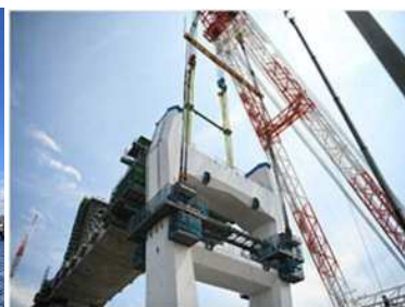
MP3橋脚(架設状況)
