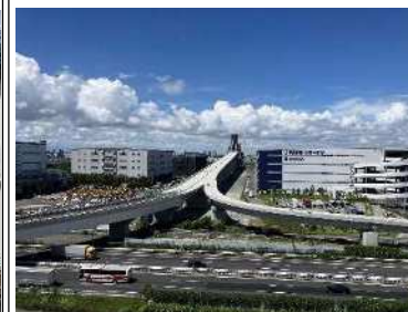
3工区・OFFランプ
