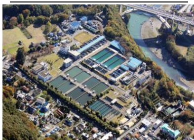
谷ヶ原浄水場の概要（再整備前）
