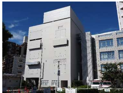
川崎病院エネルギー棟
