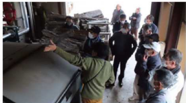
温浴施設の薪ボイラー
