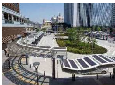
歩車分離の図られた駅前広場
