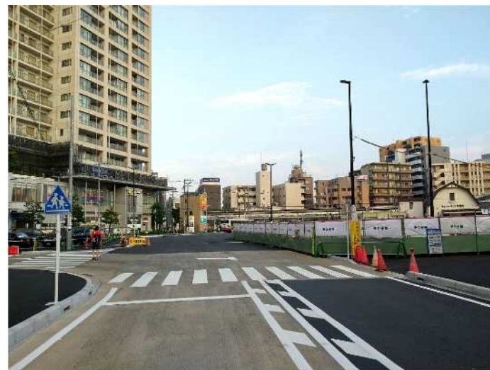
登戸1号線（向ヶ丘遊園駅付近）
