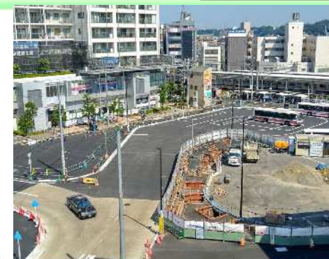
R6.8現在の現場写真
