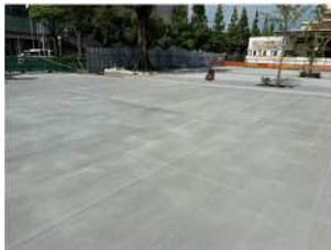
エントランス広場の 舗装仕様変更 (インターロッキング →コンクリート舗装)
