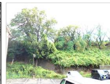
擁壁で支えられている樹林地 (Aの方向から撮影)
