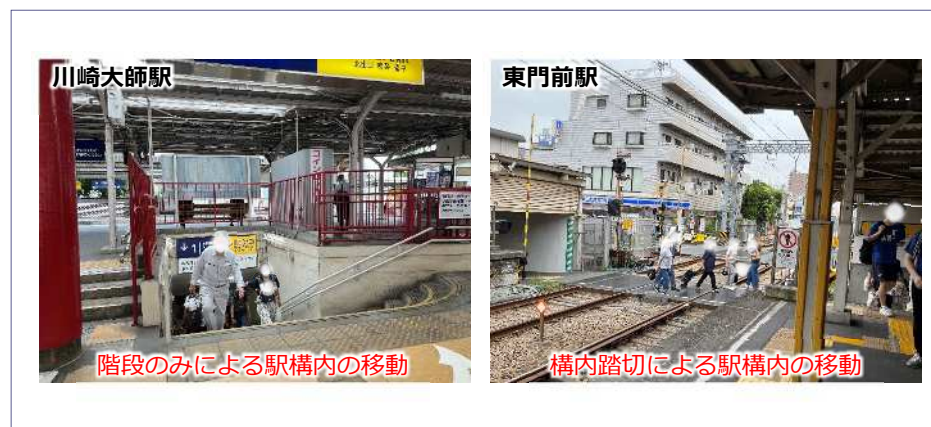
写真2 現在の駅構内の移動状況
