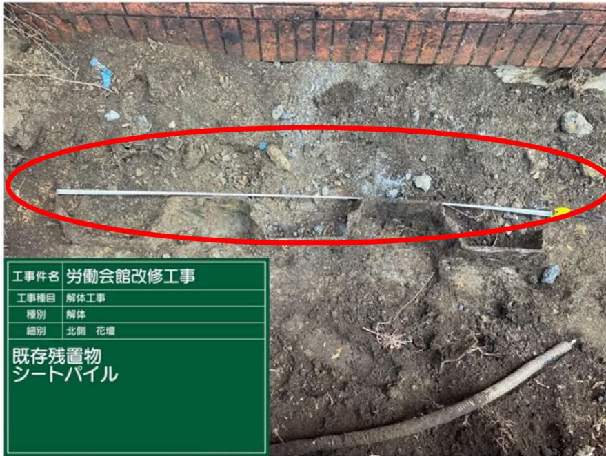
【埋設シートパイル】
