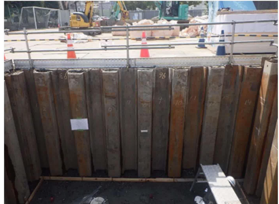
【他工事での事例】
