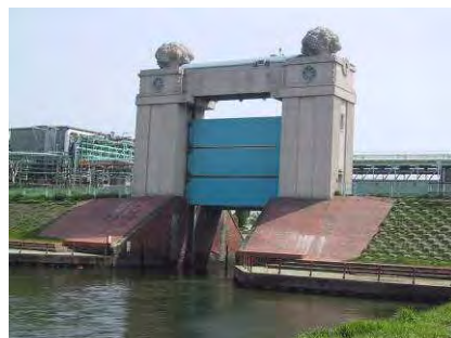
川崎河港水門
