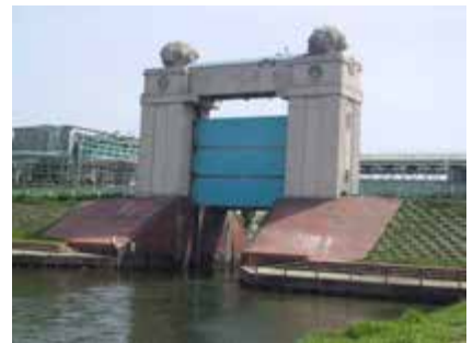
川崎河港水門
