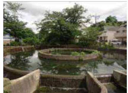
二ヶ領用水久地円筒分水
