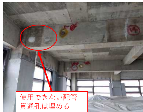
【設計図と異なる配管貫通孔の数】
