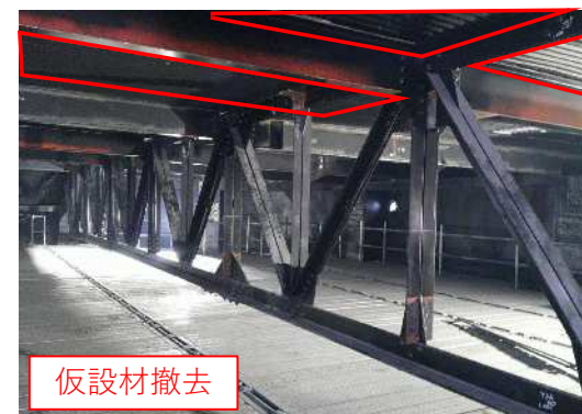
【仮設材撤去状況】
