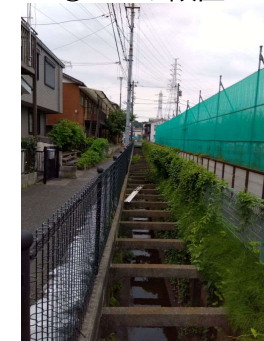
①土のう設置
