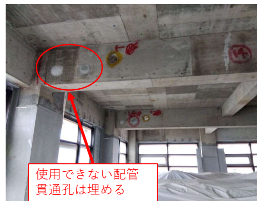
【設計図と異なる配管貫通孔の数】
