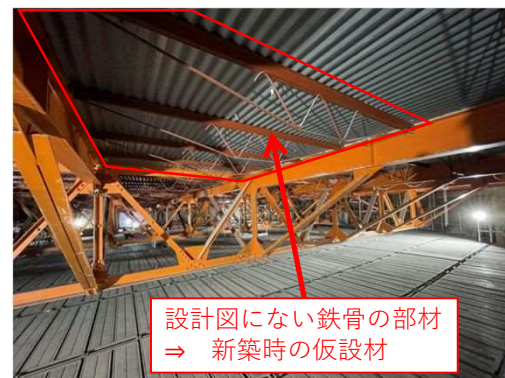
【②－3：大ホール屋根鉄骨梁の違い】
