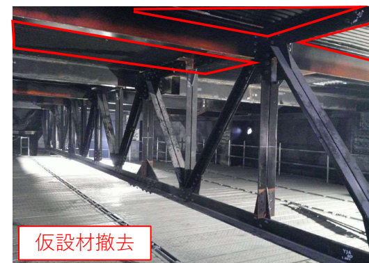
【仮設材撤去状況】
