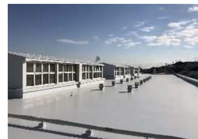
屋上防水改修
