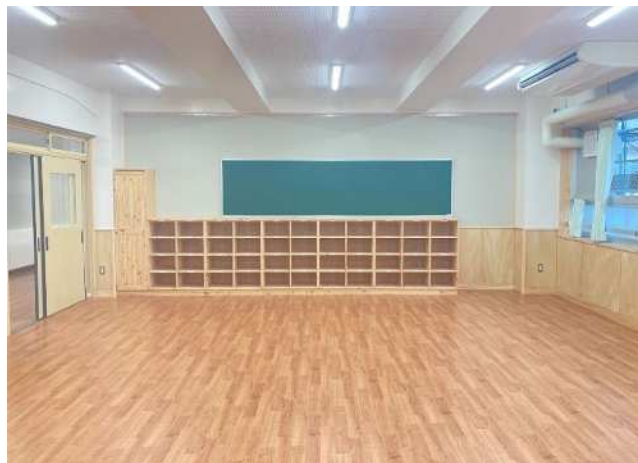
内装改修（普通教室）
