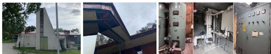
躯体の劣化が著しいエネルギー棟 渡り廊下軒裏の破損 ボイラー 消火設備 受変電設備（耐用年数を越えた設備）
