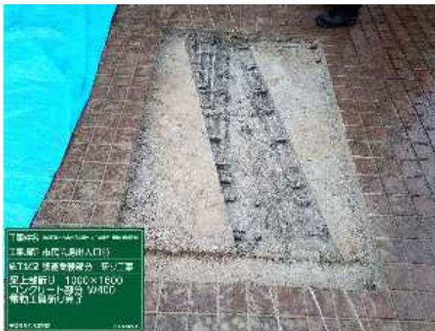
鉄筋切断状況（床面）
