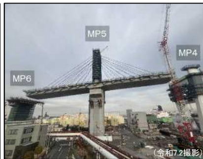
③主橋梁部MP4～MP6
