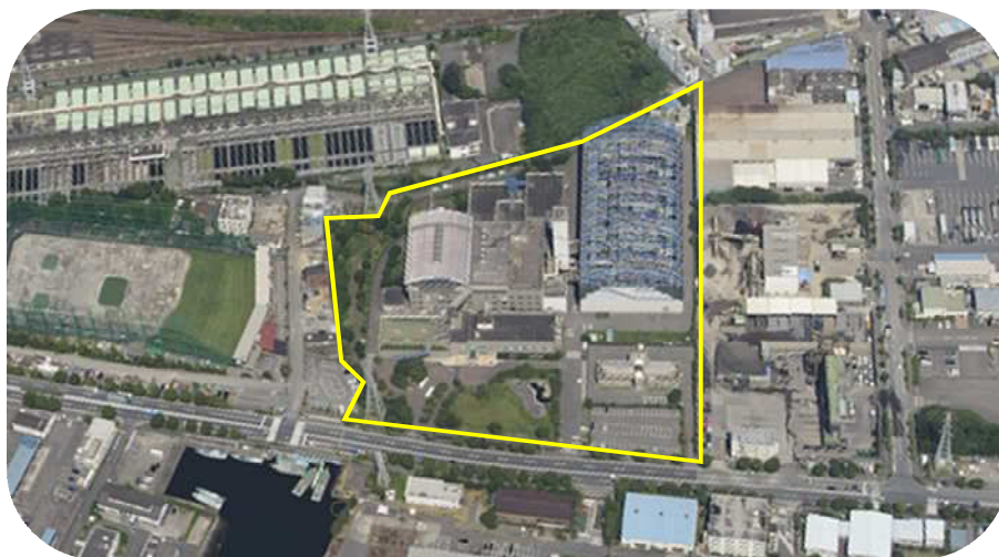
入江崎総合スラッジセンター
