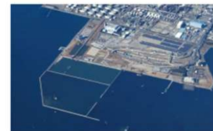
浮島2期廃棄物埋立処分場
