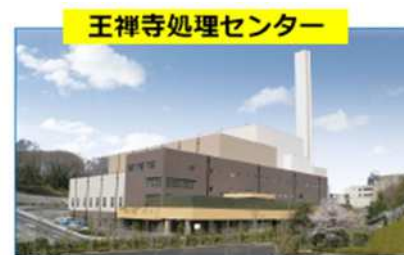
H24年3月竣工
