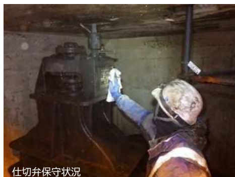
仕切弁保守状況
