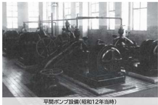
平間ポンプ設備(昭和12年当時)
