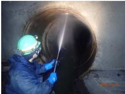
管きよ清掃状況
