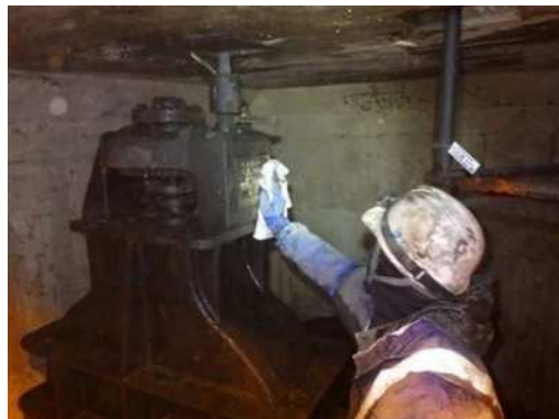
仕切弁保守作業
