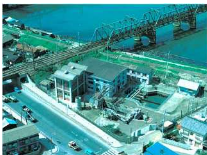
六郷ポンプ場(更新前)
