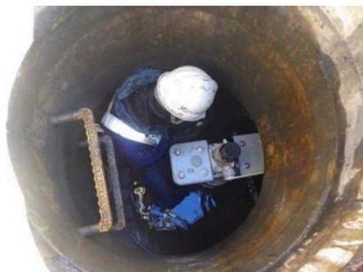
空気弁保守作業
