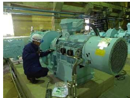
施設の点検(ポンプ設備定期点検)
