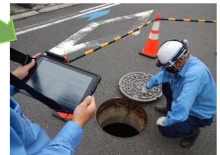
タブレットを用いた管きよの点検
