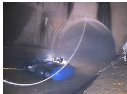
浮流式テレビカメラ調査実施状況
