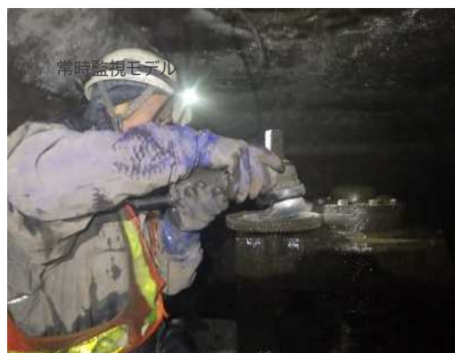
仕切弁保守作業
