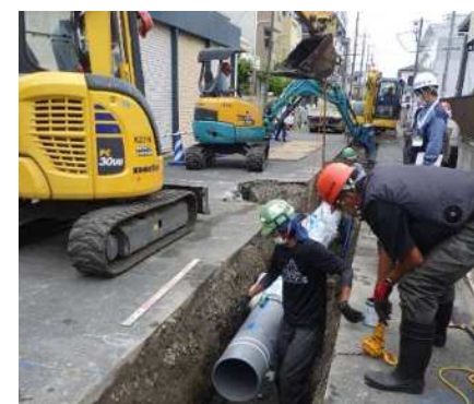
小口径管路(口径300mmの更新例(開削工法))
