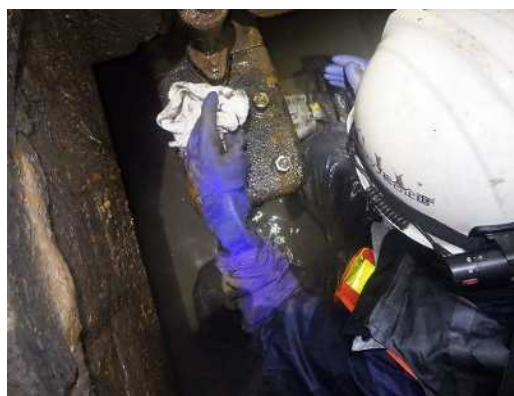
空気弁保守作業
