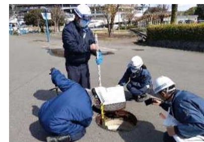
震災時下水道被害状況調査訓練
