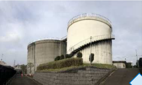
千代ヶ丘配水塔(更新前)
