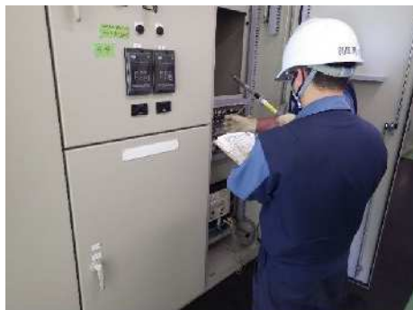
施設の点検(電気設備定期点検)
