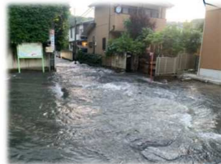
老朽化した水道管による漏水(冠水)
