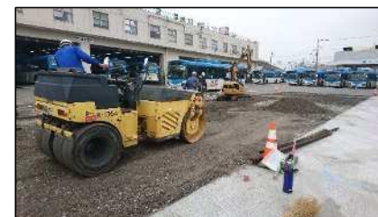
営業所車庫の路面補修
