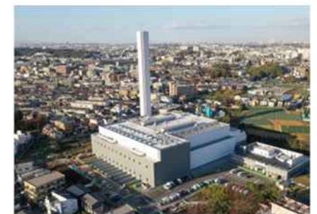
図 橘処理センター
