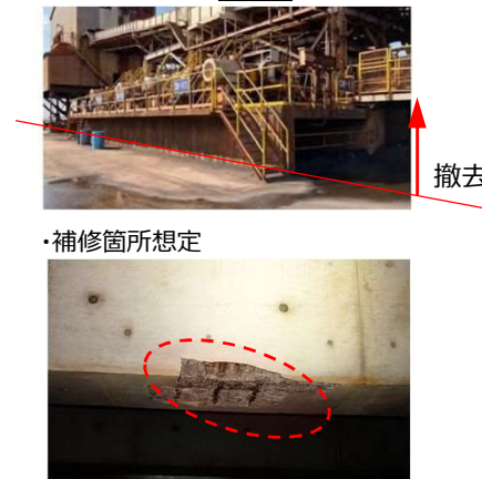
図4 撤去・補修箇所イメージ
