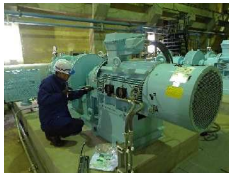
施設の点検(ポンプ設備定期点検)
