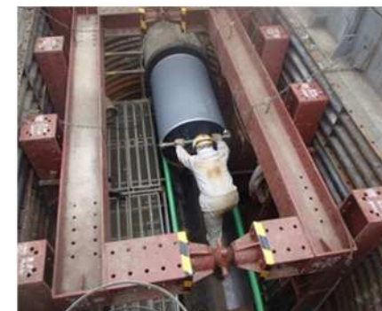
大口径管路(口径1,000mmの更新例(パイプ・イン・パイプ工法))
