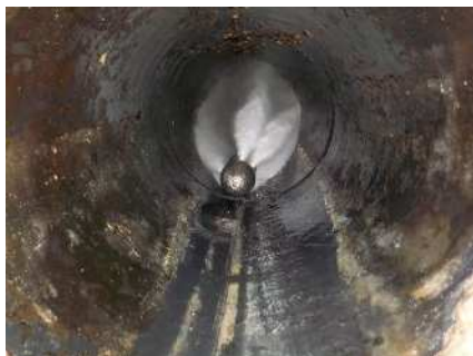
高圧洗浄ノズルによる管きよ清掃状況
