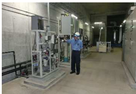
施設の点検(水質計器定期点検)
