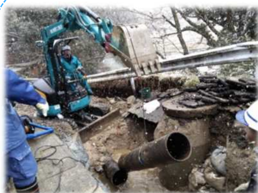
地震で損傷した水道管 (横浜市提供)
