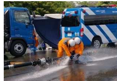
水道技能スペシャリストによる 漏水修理実演
