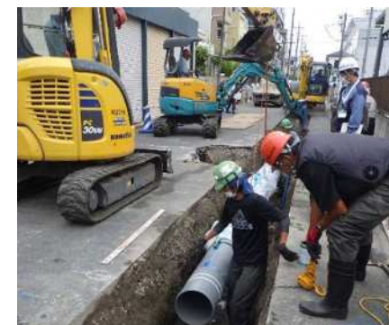
小口径管路(口径300mmの更新例(開削工法))
