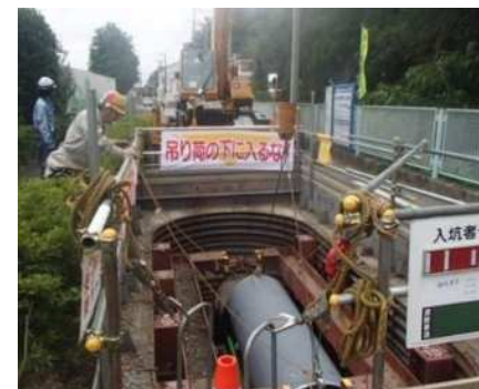
大口径管路(口径1,000mmの更新例(パイプ・イン・パイプ工法))
