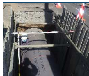
【参考】布設替工法(イメージ)
