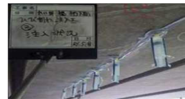
橋りょう桁下の予防保全的な修繕の例(ひび割れに樹脂を注入) (出典:川崎市橋りょう長寿命化修繕計画)
