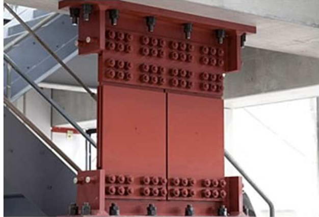
制振構造イメージ 出典：住友ゴム工業HP
