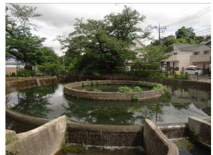
二ヶ領用水久地円筒分水
