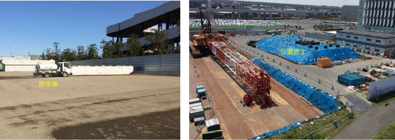
写真 2-54 粉塵対策(左：散水車による散水状況、右：仮置き土ブルーシート養生)
