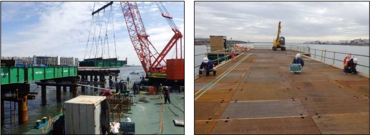
写真 2-4 工事状況(左：作業構台設置状況、右：作業構台 組立完了全景)
