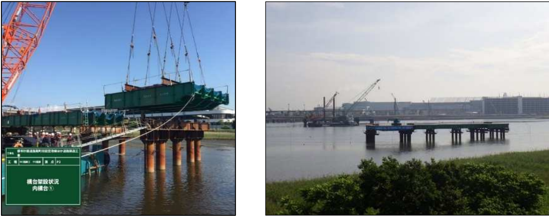
写真 2-5 工事状況(左：作業構台設置状況(H30. 6. 5)、右：作業構台 組立完了全景(H30. 6. 15))
