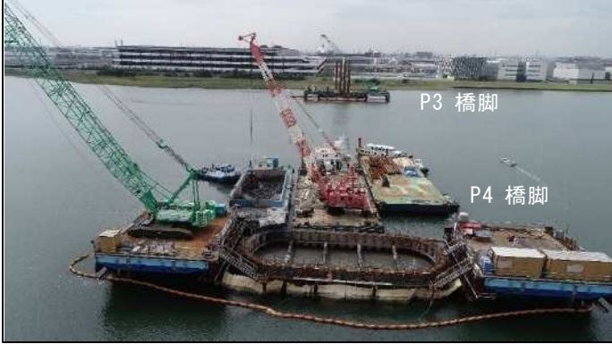
写真 2-8 鋼管井筒内掘削状況 (P4 橋脚)
