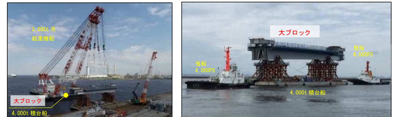
写真 2-15 工事状況(左: 大ブロック浜出し、右: 大ブロック海上運搬)
