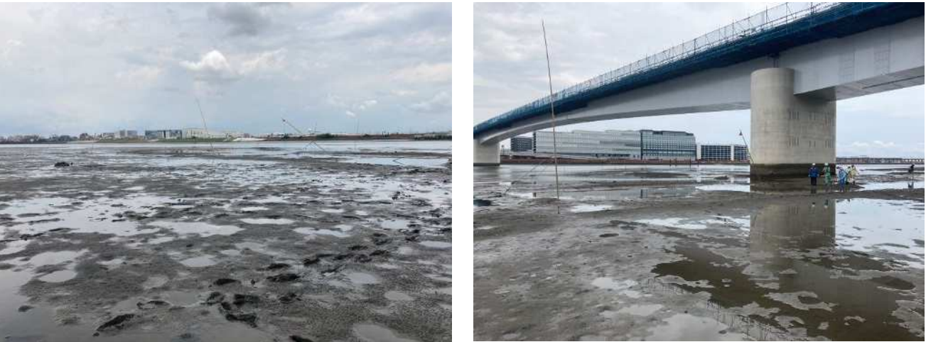
写真 2-43 埋戻し完了全景
