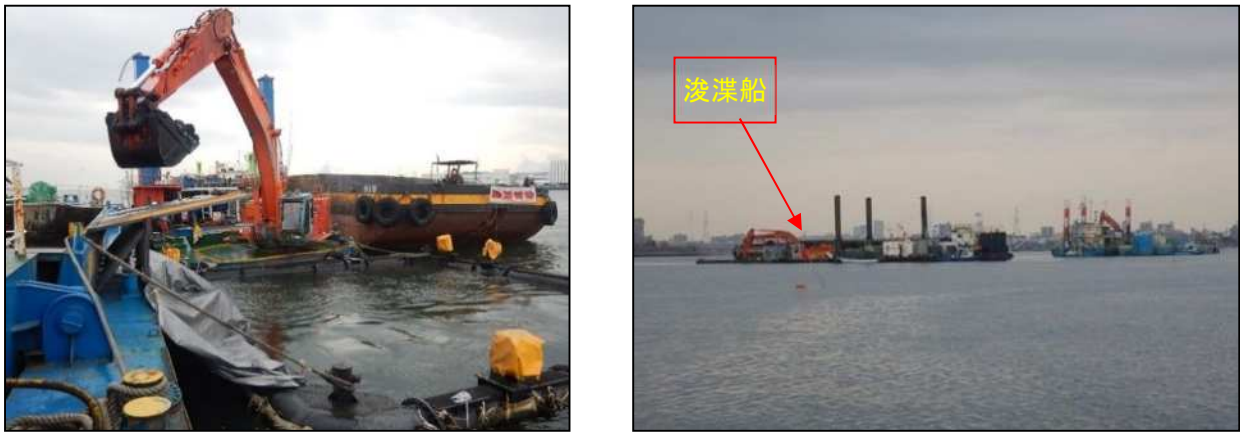
写真 2-2 工事状況(左：浚渫状況(近景)、右：築造部の浚渫状況)
