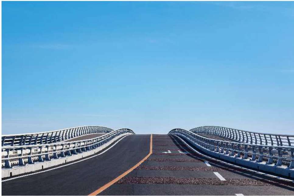
図 2-27 突出物の少ない橋上の状況
