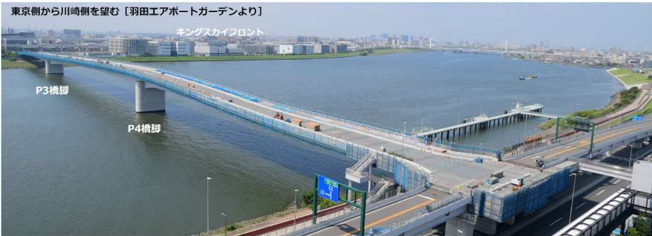
写真 2-31 橋梁部地覆コンクリート実施状況
