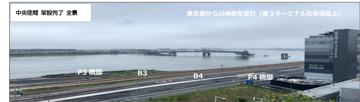
写真 2-22 中央径間 架設完了 全景
