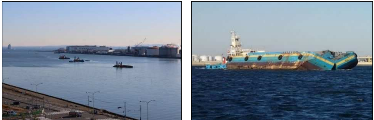
写真 2-3 工事状況(左航路部の浚渫状況：、右：浚渫土砂投入状況(浮島処分場))
