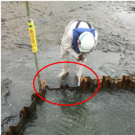
写真 2-36 実施状況(左：矢板打下げ状況(帯水対策)、右：緩衝帯地形変化確認状況)
