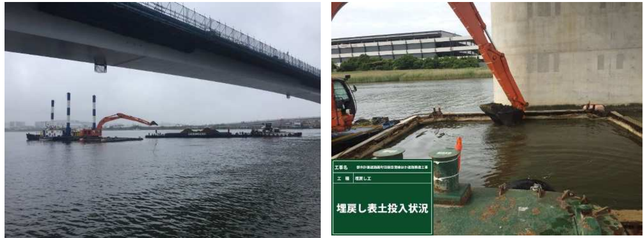
写真 2-42 埋戻し土投入状況
