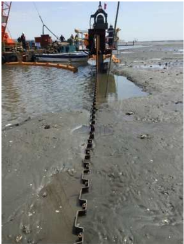
写真 2-35 生態系保持空間の保護(仮設鋼矢板設置)の実施状況
