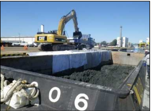
写真 2-38 干潟部保護に配慮した浚渫工の実施状況(左：表土陸揚げ状況、右：表土保管状況)
