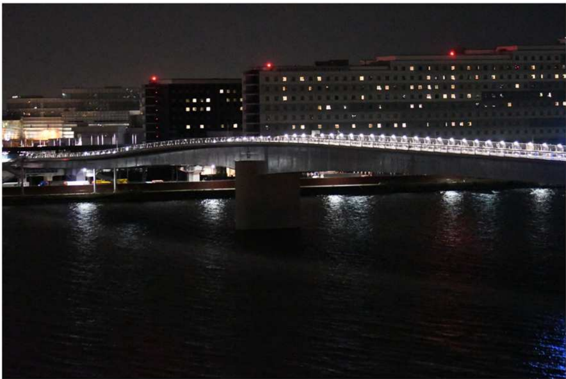
図 2-28 低位置照明の設置状況
