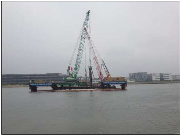
写真 2-6 鋼管矢板打設状況全景
