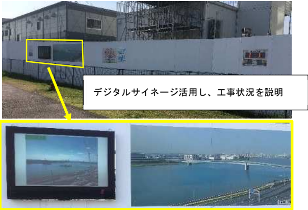
写真 2-55 電光掲示板による説明状況(多摩川サイクリングロード沿い)
