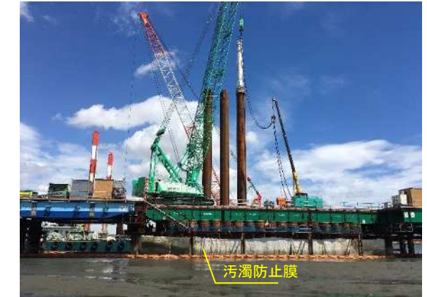
写真 2-46 汚濁防止膜設置状況(左：浚渫時、右：鋼管矢板打設時)
