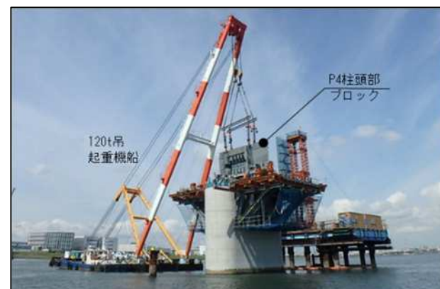
写真 2-13 工事状況(左: 柱頭部 鋼桁据付、右: 剛結部コンクリート打設)
