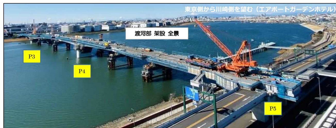
写真 2-26 渡河部架設全景
