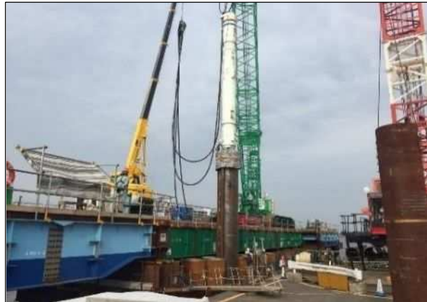
写真 2-7 工事状況 (左：鋼管矢板打設状況 (P4 橋脚)、右：鋼管矢板打設完了 (P4 橋脚))
