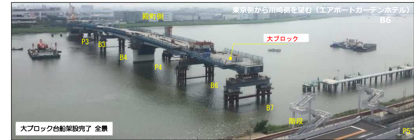
写真 2-23 大ブロック台船架設完了 全景
