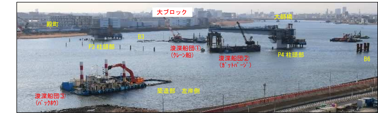
写真 2-18 造部(右岸・左岸)浚渫状況
