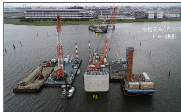
写真 2-12 橋脚躯体コンクリート完成
