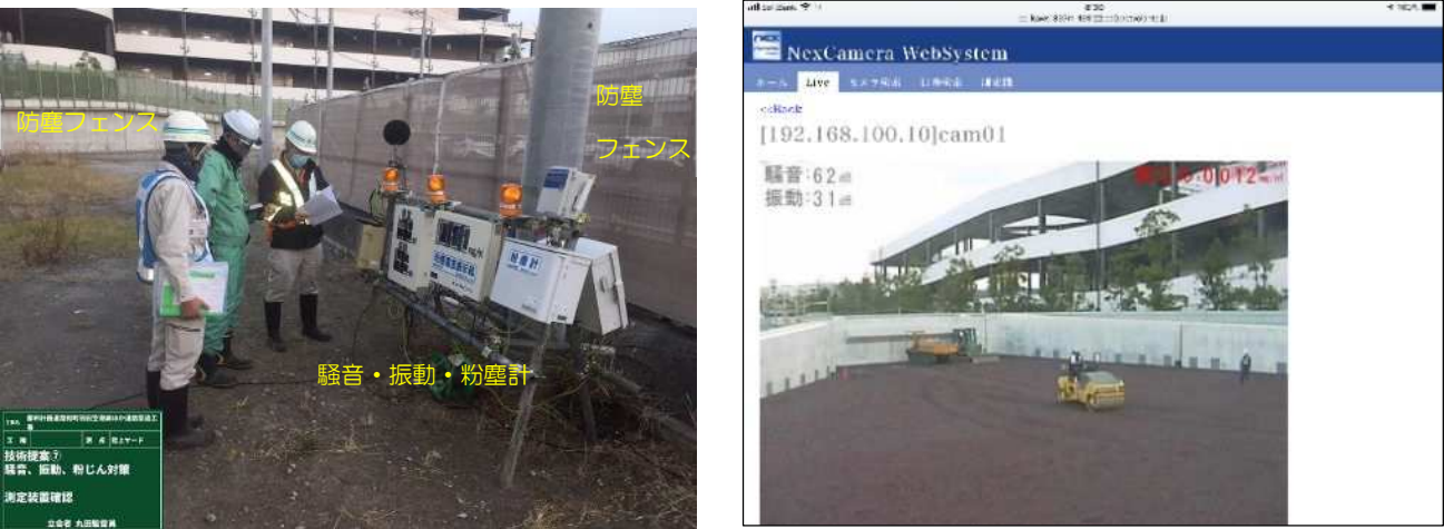
写真 2-53 粉塵対策(左：騒音・振動・粉塵計、右：モニタリング画面)
