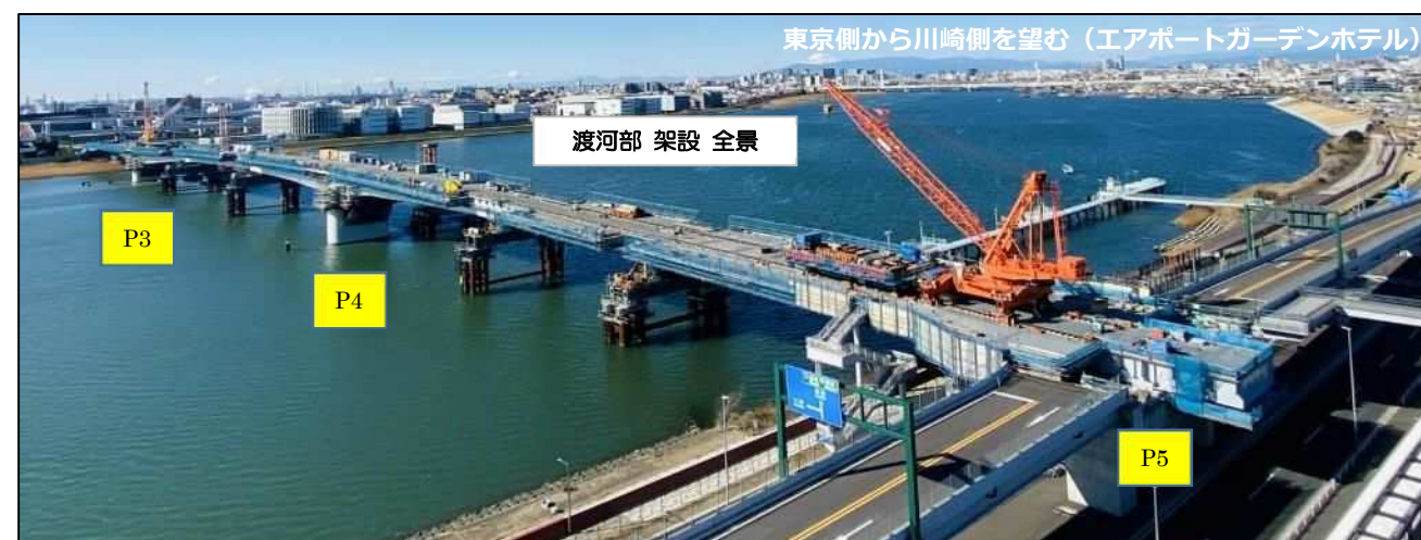
写真 2-26 渡河部架設全景
