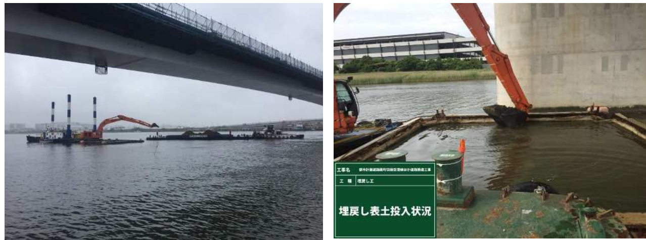
写真 2-42 埋戻し土投入状況
