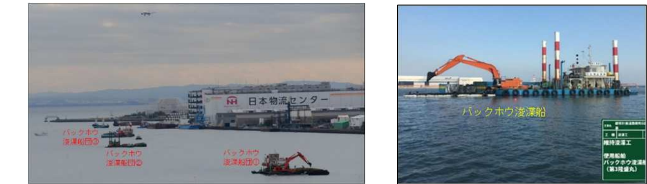
写真 2-19 (左：航路部浚渫状況、右：浚渫(バックホウ浚渫船)状況)
