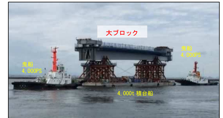
写真 2-15 工事状況(左: 大ブロック浜出し、右: 大ブロック海上運搬)
