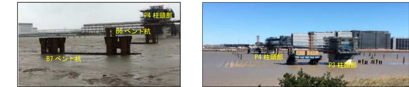
写真 2-17 東日本台風通過時状況
