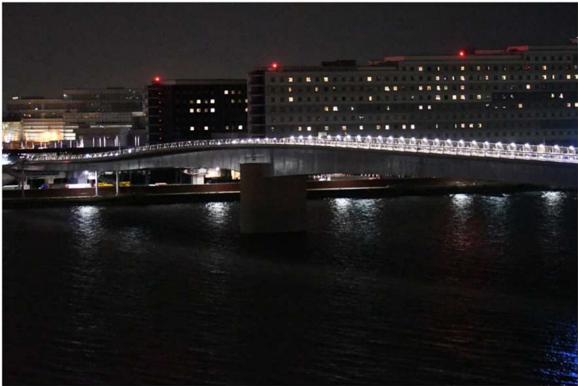
図 2-28 低位置照明の設置状況
