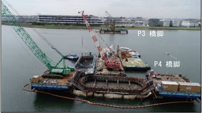
写真 2-8 鋼管井筒内掘削状況 (P4 橋脚)
