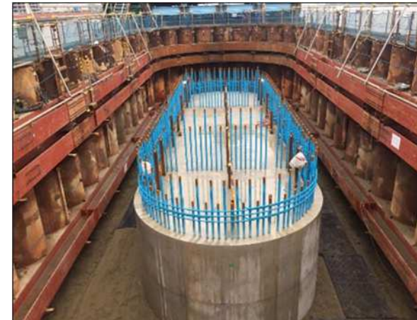
写真 2-11 井筒内埋戻し状況
