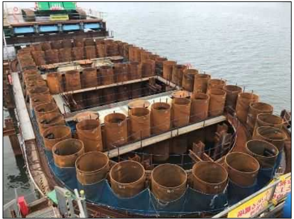
写真 2-7 工事状況 (左：鋼管矢板打設状況 (P4 橋脚)、右：鋼管矢板打設完了 (P4 橋脚))
