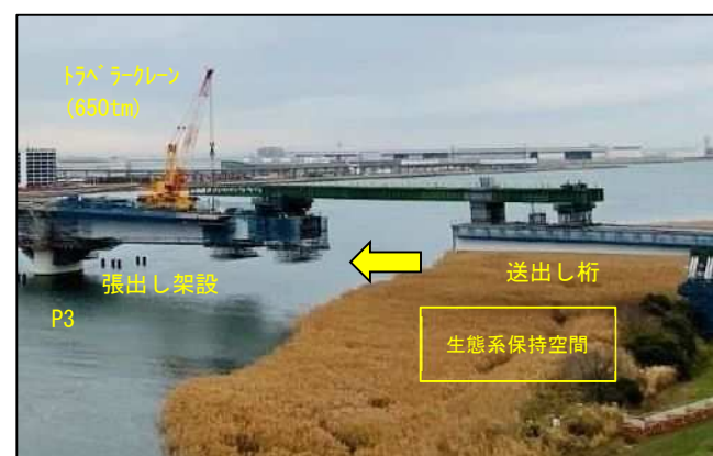
写真 2-25 右岸側(左：張出し・送出し架設、右：側床版架設)
