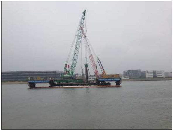
写真 2-6 鋼管矢板打設状況全景
