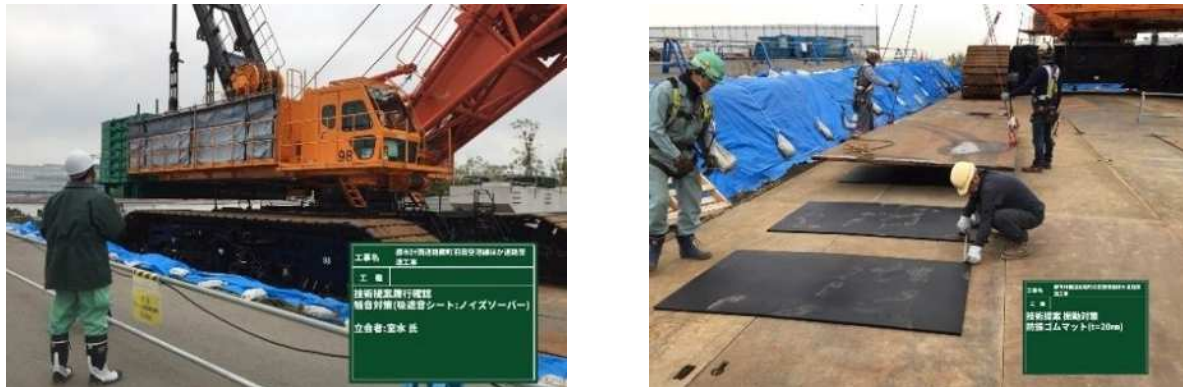
写真 2-52 騒音・振動対策(左：吸遮音シート設置、右：防振ゴムマット設置)
