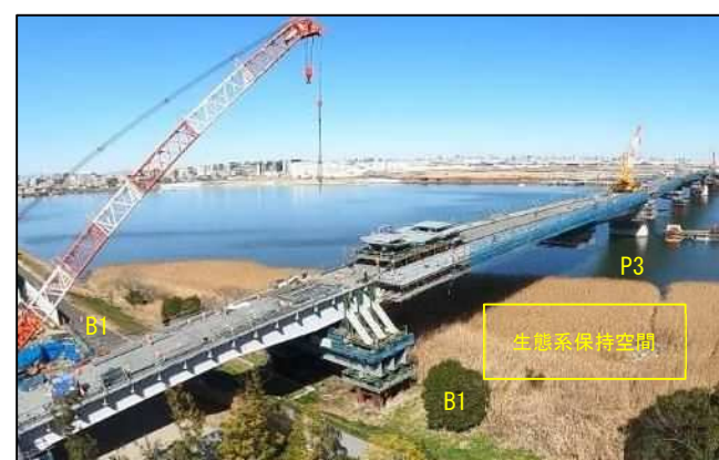
写真 2-25 右岸側(左：張出し・送出し架設、右：側床版架設)
