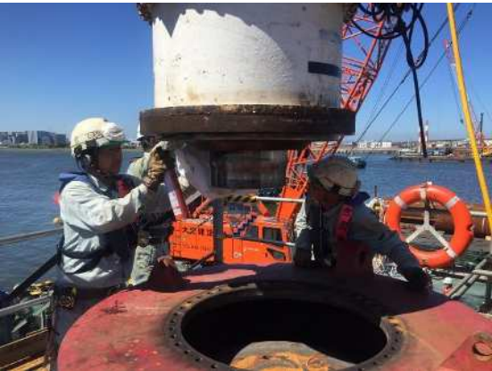
写真 2-56 始業前点検状況(ベント基礎杭打設用油圧ハンマ)
