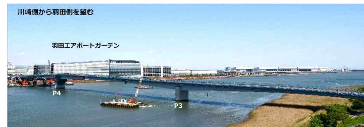
写真 2-27 ベント設備撤去状況
