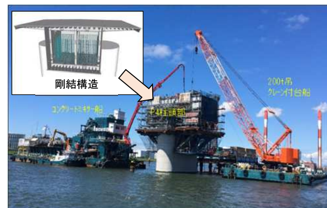
写真 2-13 工事状況(左: 柱頭部 鋼桁据付、右: 剛結部コンクリート打設)
