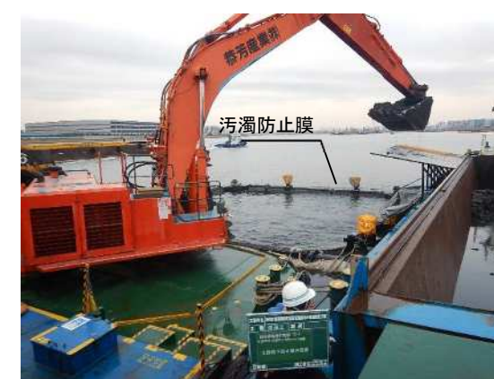
写真 2-46 汚濁防止膜設置状況(左：浚渫時、右：鋼管矢板打設時)
