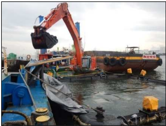
写真 2-2 工事状況(左：浚渫状況(近景)、右：築造部の浚渫状況)
