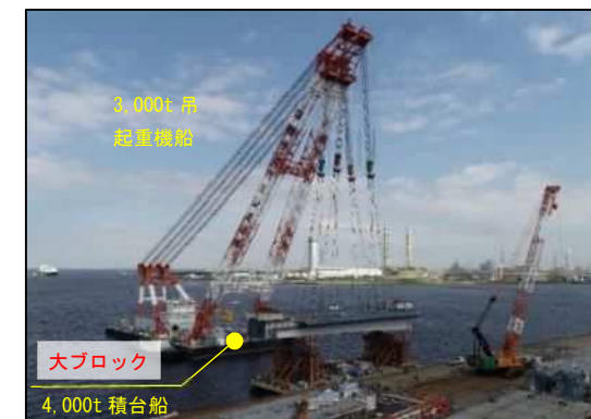
写真 2-15 工事状況(左: 大ブロック浜出し、右: 大ブロック海上運搬)
