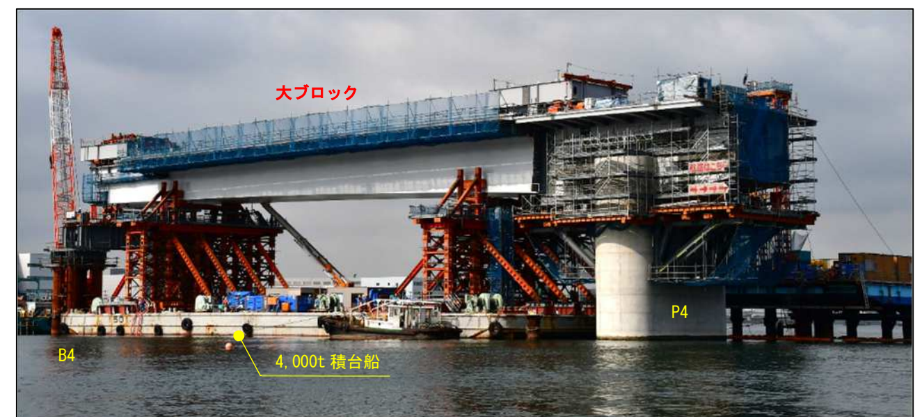
写真 2-16 大ブロック台船架設
