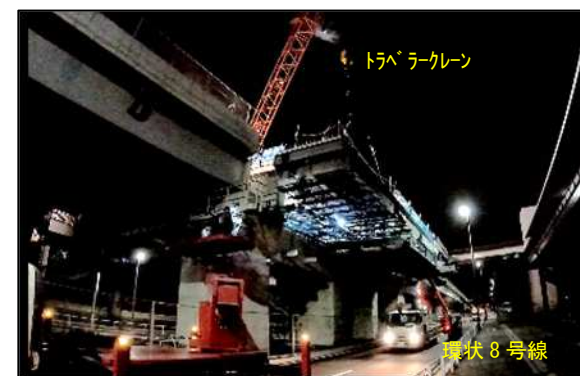
写真 2-24 左岸側(左：張出し架設、右：張出し架設(夜間規制))
