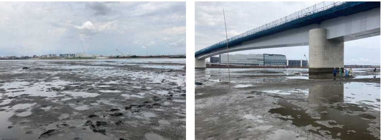
写真 2-43 埋戻し完了全景
