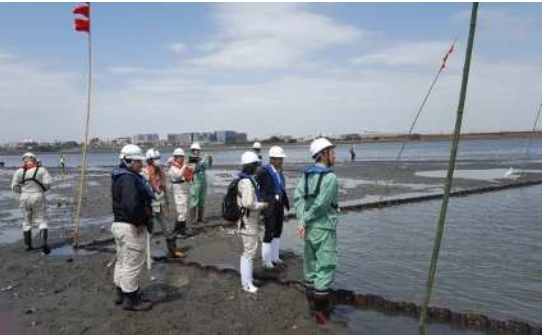
写真 2-35 生態系保持空間の保護(仮設鋼矢板設置)の実施状況
