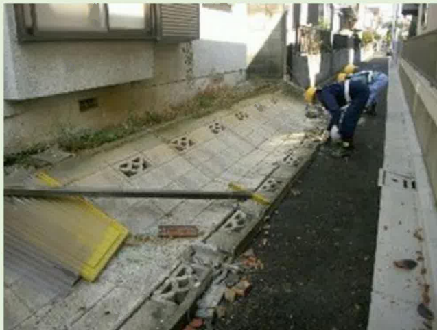
塀等の倒壊で道路が閉塞しやすい
